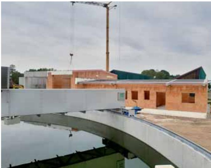
Die Baumaßnahmen in der neuen Kläranlage schreiten weiterhin zügig voran. Die Rohbauarbeiten wurden zwischenzeitlich bereits zu 90 % abgeschlossen. Dem schließen sich weiter der Gewerkeausbau an. Begonnen wird mit den Dacheindeckungsarbeiten. Anschließend folgt der Einbau von Fenstern, Toren und Türen, bevor mit den Putzarbeiten die Ausbaurbeiten am Betriebsgebäude abschließen.
