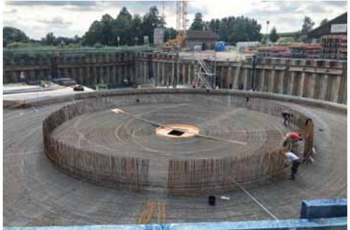
Die Bodenplatte des Klärbeckens wurde betoniert. Nun werden die beiden Ringwände nach und nach in Segmente betoniert. Diese Arbeiten dauern bis etwa Ende Oktober. Danach geht es mit dem Schlammstapelbehälter weiter.
