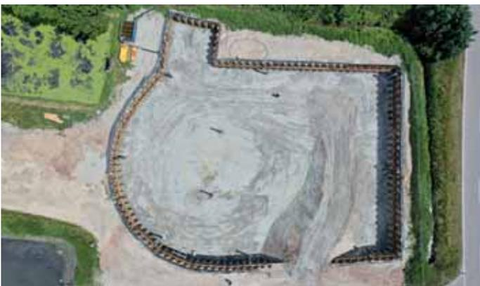
Baugrube im Bereich des sogenannten "Königstuhles" in der Mitte des Kombibeckens ausgehoben werden. Dies bedeutet, dass man in diesem Bereich nochmals ca. 3,50 Meter in die Tiefe graben muss.
